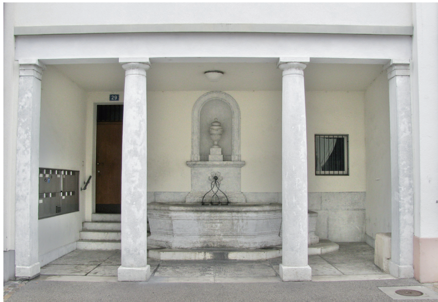
Ilustracja 3. Wodociek na ul. Nadelberg. Fot. W. Muras
